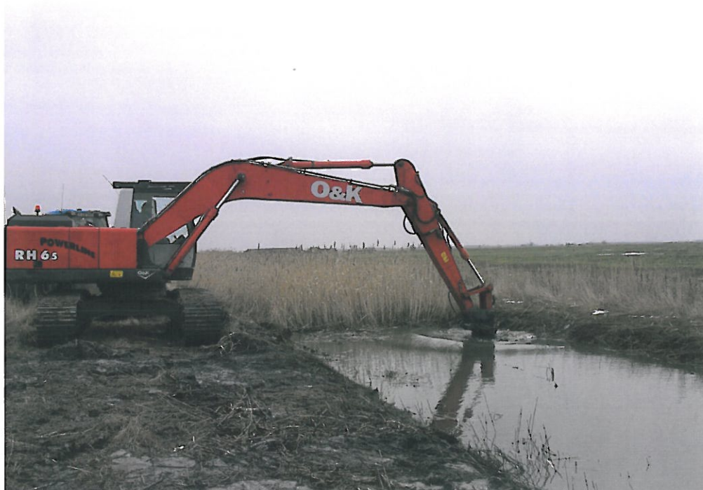
V-II-6 csatorna preventív kotrása 7+000 körül (2011.01.21.)
