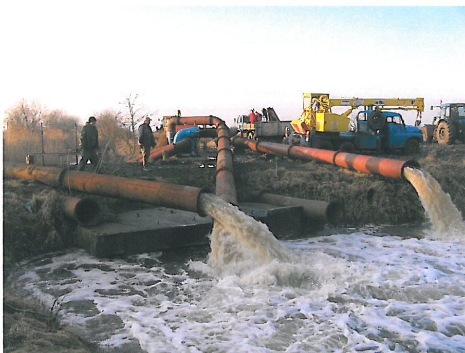
Csátés belvízesatorna mobil szivattyús felvonulás
