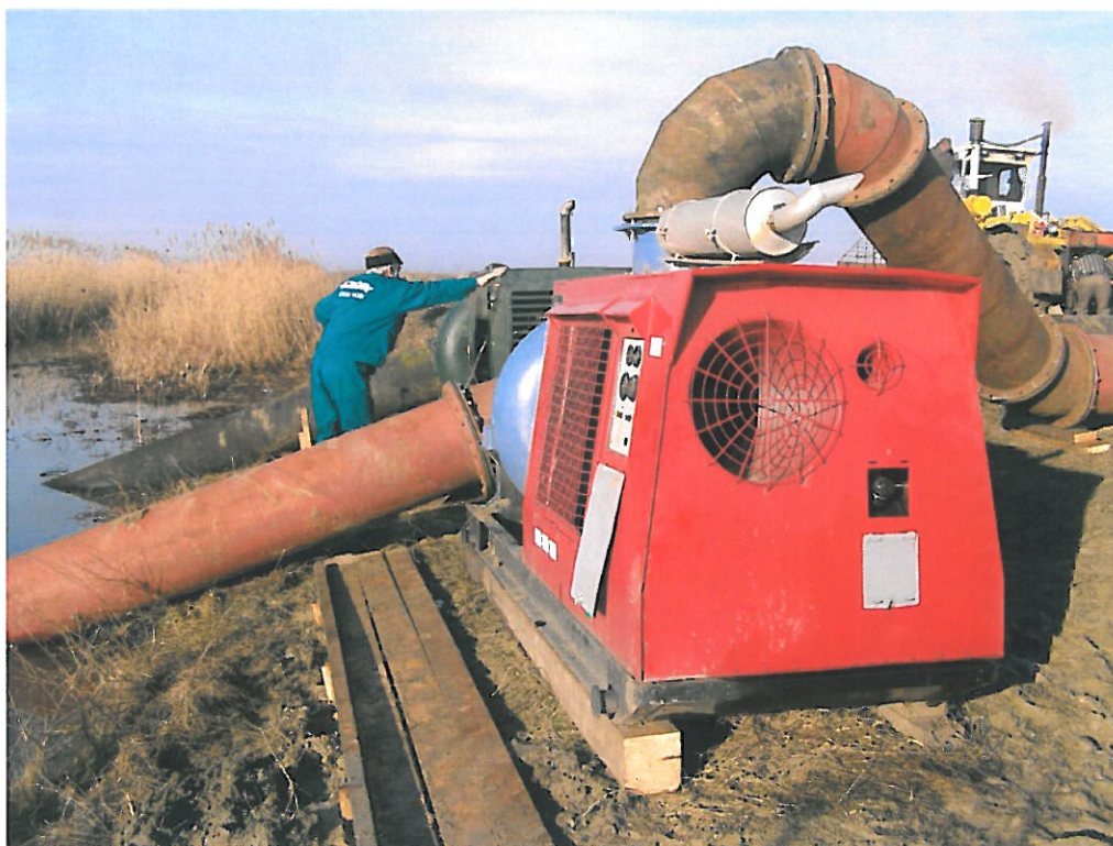
Mobil szivattyúzás a Német-érből a Nagyiváni tározóba
