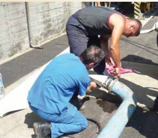
Víztelenítő szivattyú összeszerelése
