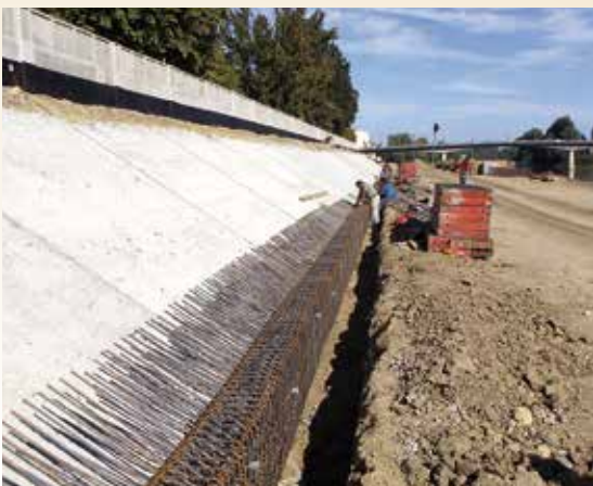
Készül a támerenda vasalása Szolnokon, a belvárosi szakaszon
