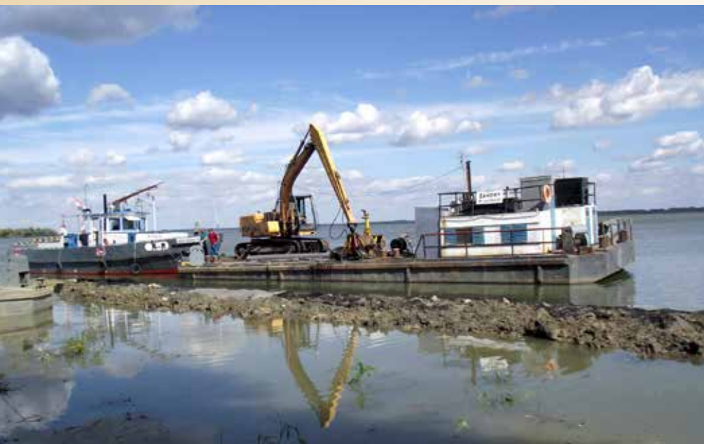
A Tisza-tó jobb partján, a 146+120 - 146+280 szelvények között a vízről épül a partvédelmi kőmű
