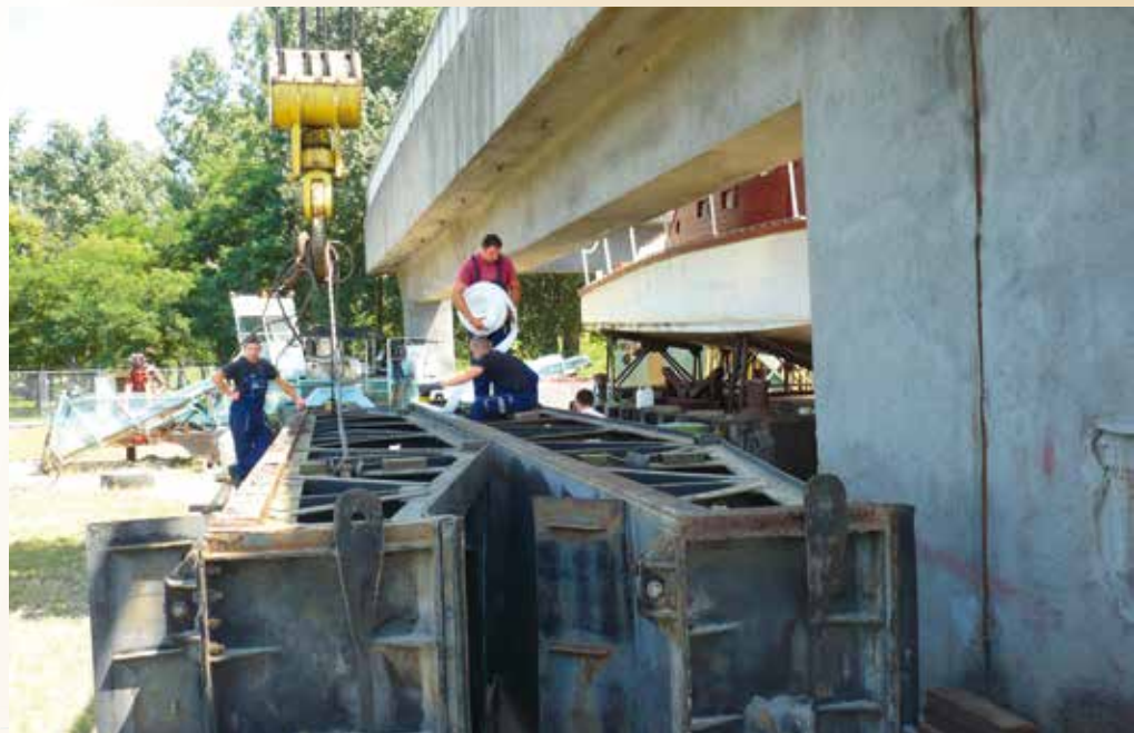
Elzáró táblák előkészítése
