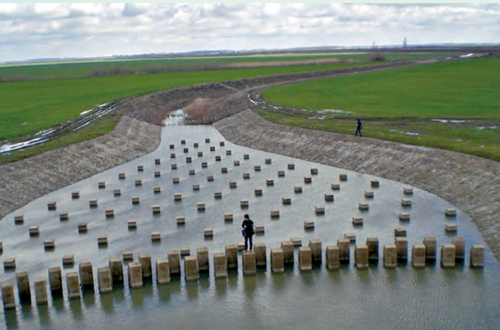
Tiszaroffi tározó déli műtárgy energiatoró fogai
